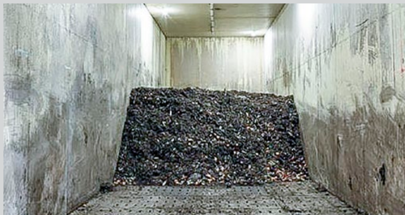
Abb. 15: Rottetunnel mit flächiger Bodenbelüftung der Firma Linz AG in der Kompostieranlage Linz (A).
